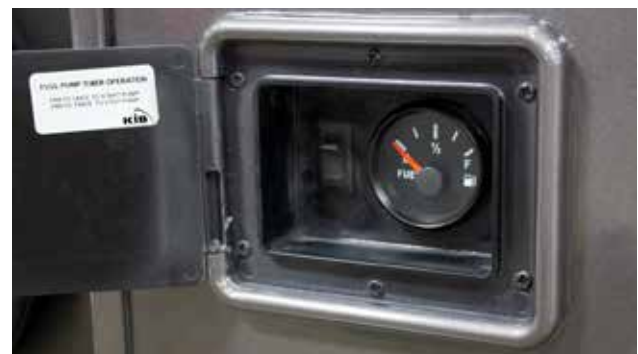
Interrupteur de pompe à carburant et jauge de carburant pour le système de transfert de carburant
