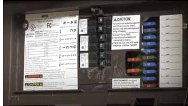
Disjoncteur et panneau de fusibles typiques de 30 A. Notez les étiquettes des circuits et des appareils.
