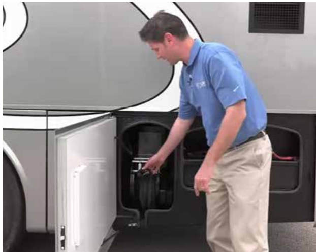
Cordon secteur 50 A sur l'enrouleur électrique.
