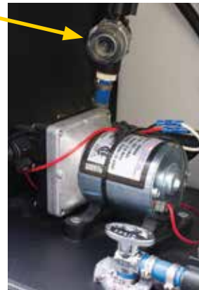
Installation typique de pompe à eau
