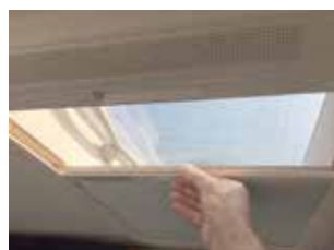
Puits de lumière et pare-soleil intégré
