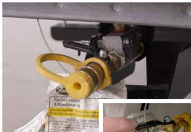
(Ci-dessus) Orifice de branchement externe typique pour le propane. (A droite) vanne d'arrêt de gaz manuelle.
