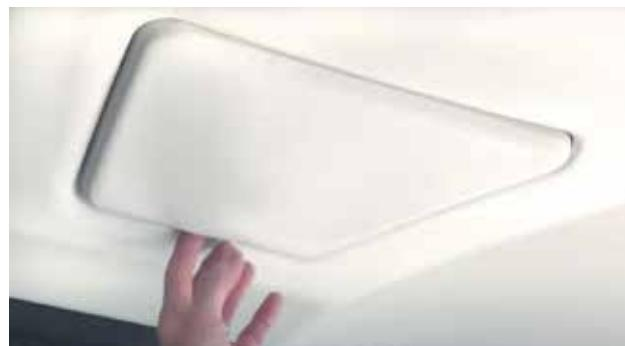
Figure 1. Panneau d'accès au moteur.
