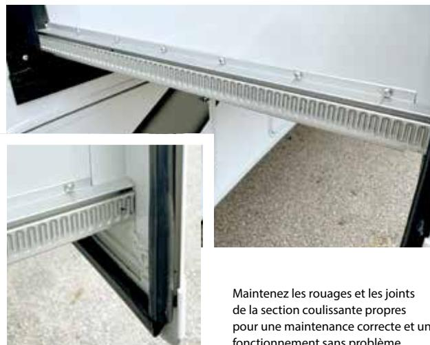
Maintenez les rouages et les joints de la section coulissante propres pour une maintenance correcte et un fonctionnement sans problème
