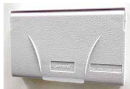
Prise extérieure typique de 120 volts CA protégée par un disjoncteur différentiel.
