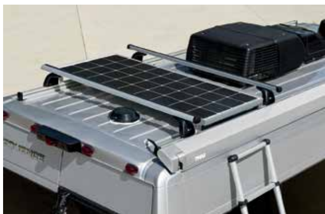
Installation typique de panneaux solaires
