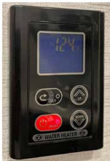
Chauffe-eau sans réservoir Panneau de commande de l'utilisateur (UCP) monté sur une paroi de la salle de bains.
