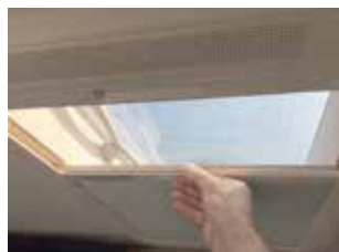
Puits de lumière et pare-soleil intégré
