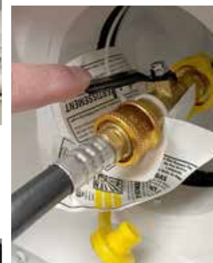
(Au-dessus) Orifice de raccord de propane externe typique. (Droite) vanne d'arrêt manuel.
