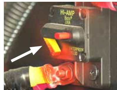
Disjoncteur de cent ampères. Relever le levier jaune pour le réajuster.
