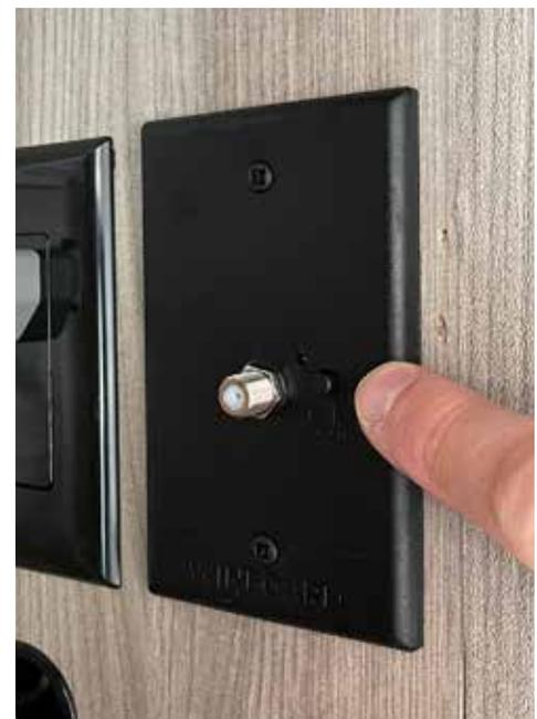
Bouton-poussoir de sélection antenne/câble avec LED verte
